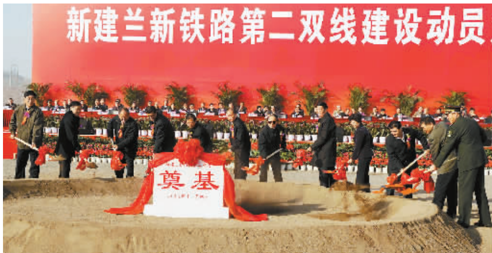
兰新铁路第二双线奠基开工现场。新华社照片
