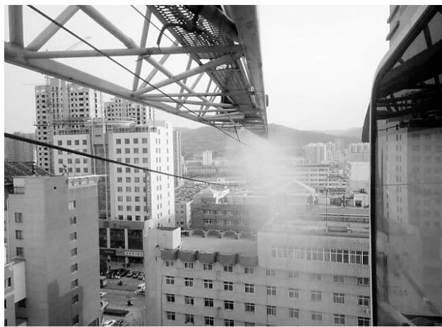
塔吊喷淋降尘。兰州晨报首席记者 王兰芳 摄
